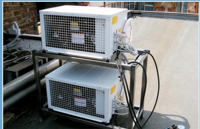
Unità refrigerante remota posizionata su struttura inox / Remote cooling unit positioned on a stainless steel frame
