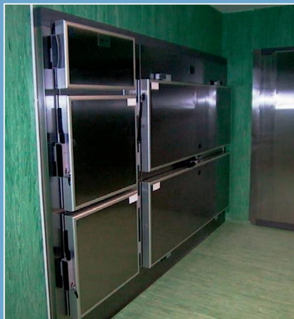
Abbinamento cella 2 posti frontale e 2 posti laterale con sportello per estrazione evaporatore
