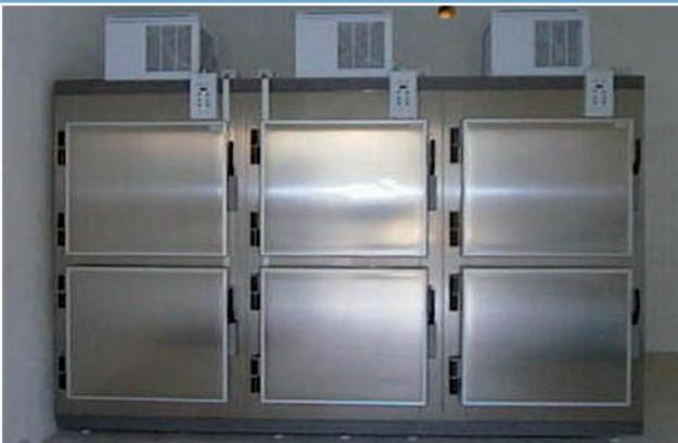
Gruppo celle a 2 posti cadauna, ognuna con proprio impianto monoblocco / *Cold rooms 2 bodies each, each cold room equipped with its own cooling unit*
