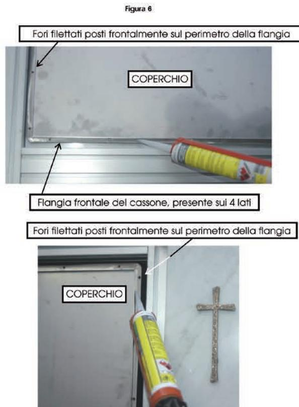
Una volta che tutti e 4 i lati del coperchio sono stati sigillati, in corrispondenza della flangia del contenitore (o cassone), procedere con il montaggio dei 4 angolari e delle rispettive viti (vedi Figura 7). Le squadrette e le viti dovranno essere avvitate e gradatamente serrate, per permettere una pressione uniforme su tutto il perimetro del coperchio contro la rispettiva flangia.
